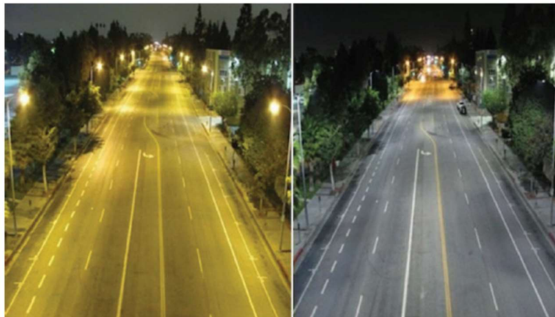
Figura 130 - Comparação entre trecho utilizando tecnologia Vapor de Sódio a esquerda e tecnologia LED a direita
